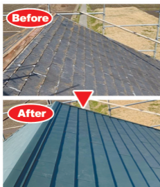
上にかぶせる「カバー工法」
